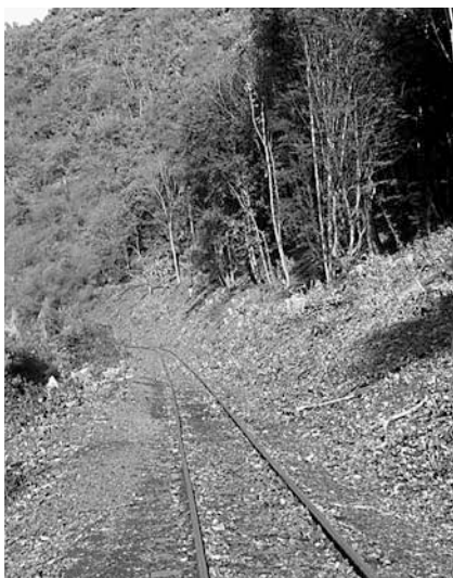
Der Gleisbereich nach dem Freischnitt.
