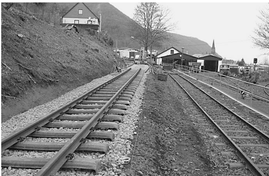
Neu verlegter, noch ungestopfter Gleisabschnitt hinter der DKW in Brohl.
