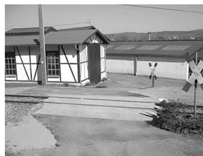
Der erneuerte Bahnübergang beim Wagenschuppen in Brohl.
