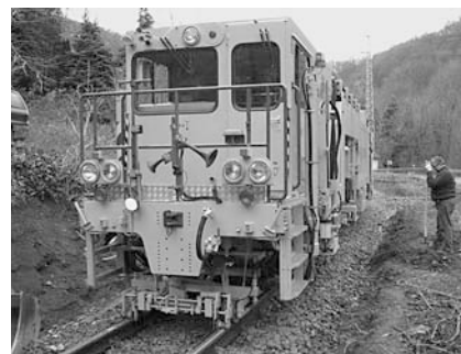
Stopfmaschine im Einsatz.
