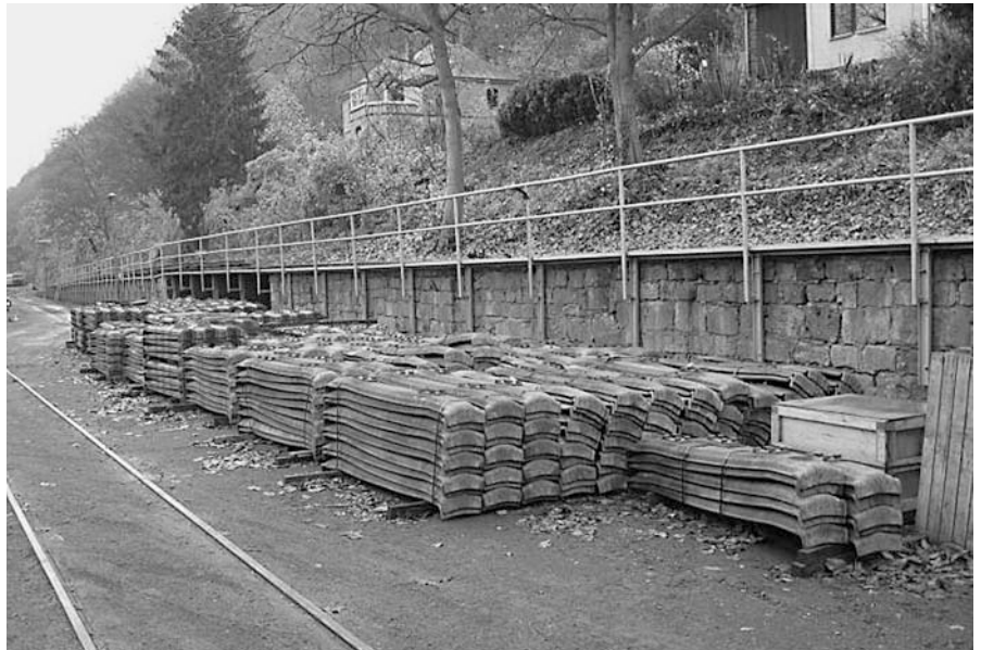
Warten auf den Einbau: neue und gebrauchte Schwellen in Brohl.
