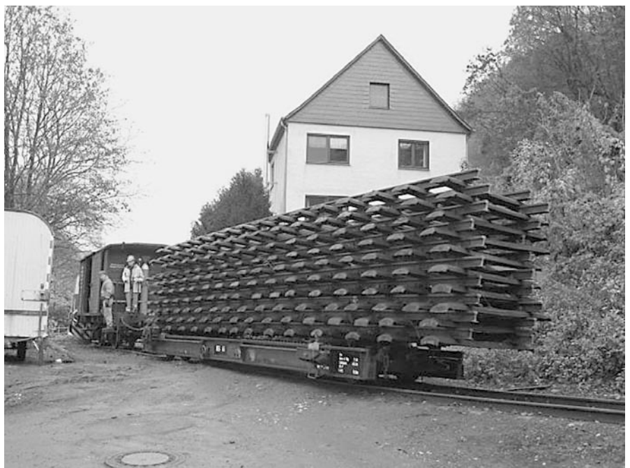
Abtransport der alten Gleisjoche.
